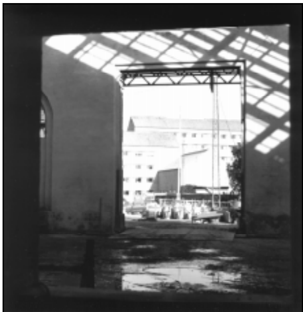
Glas til en million kroner. Ridehusets store hal bliver delt i tre rum. Mellem rummene skal der sættes glasvægge op for at bevare noget af udsigten til de gamle træ- og stålkonstruktioner i loftet.
