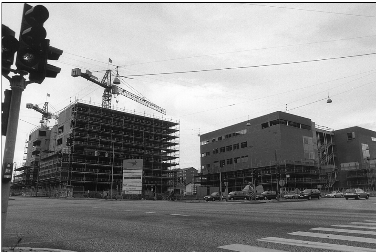
Den mest synlige af universitetets mange udvidelser lige nu er byggeriet på Barnow-grunden i krydset mellem Nordre Ringgade, Nørrebrogade og Randersvej.
