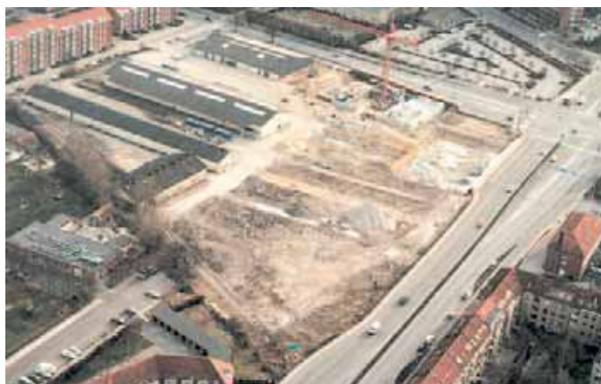
Opførelsen af Nobelparken begyndte i 1997 på grunden, hvor nogle af den tidligere tømmerhandels bygninger endnu ikke er revet ned.
